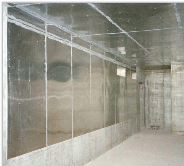
Wand-Deckenabschirmung für NS-HV und MS
